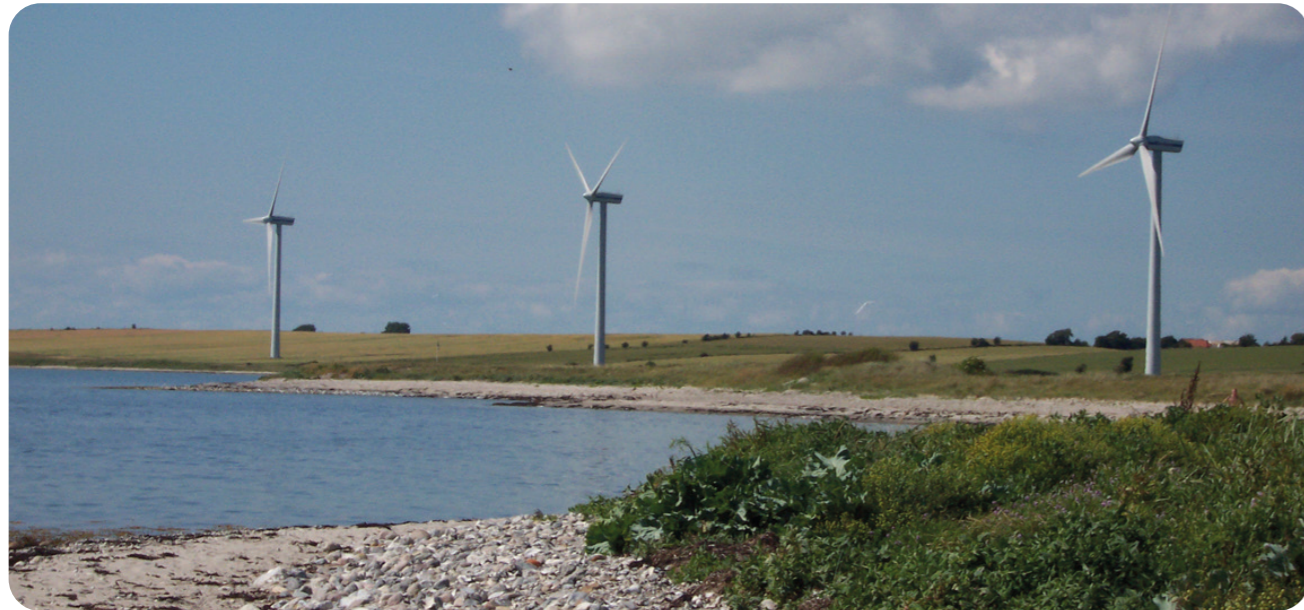
Wind turbines on Ærø. Photo: Jess Heinemann (Ærø Kommune)
