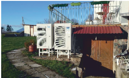
Nuotraukoje: šilumos siurbliai prie parapijos namų pastato
